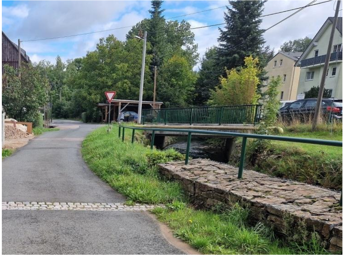
Bild 5: spitzwinklige Einmündung an der Brücke C7
