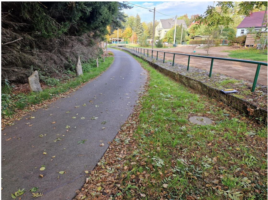
Bild 7: Schachtabdeckung östlich der Einmündung Am Försterberg
