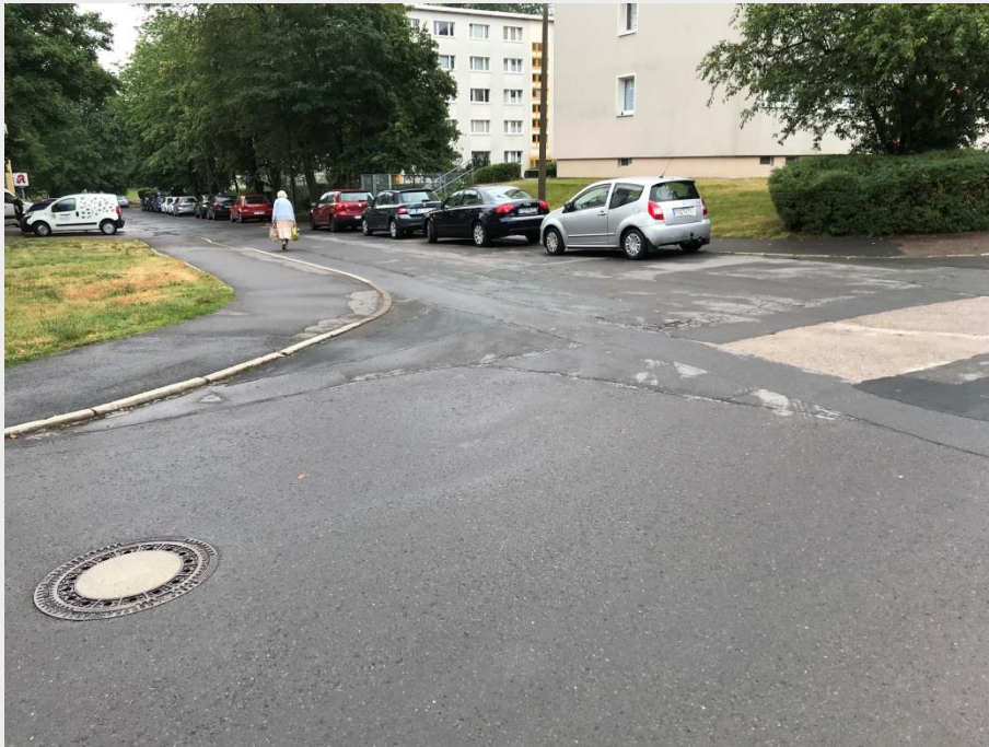
Blick in Richtung Wendehammer
