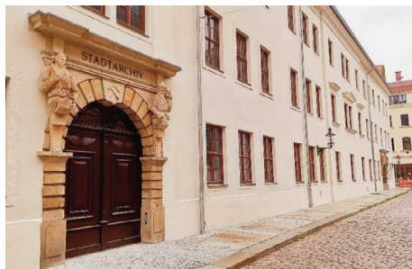
Neues Freiburger Stadtarchiv im sanierten Herderhaus
